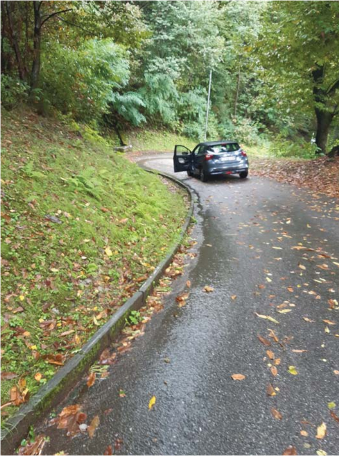
Foto 45 Acqua sulla strada
