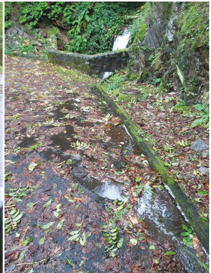
Foto 4 Imbocco tombinone, intervento 3
