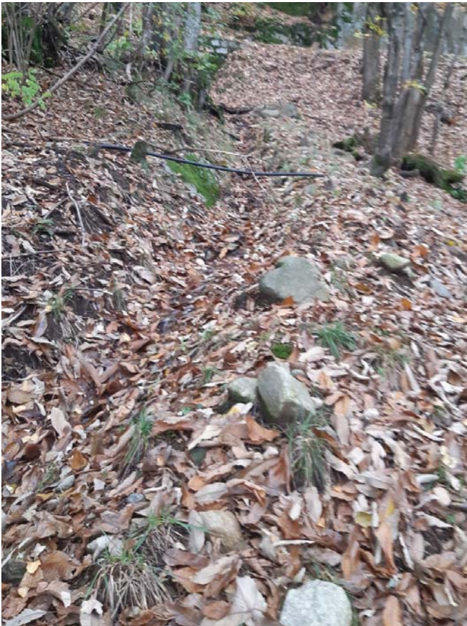
Foto 53 Canale di gronda esistente
