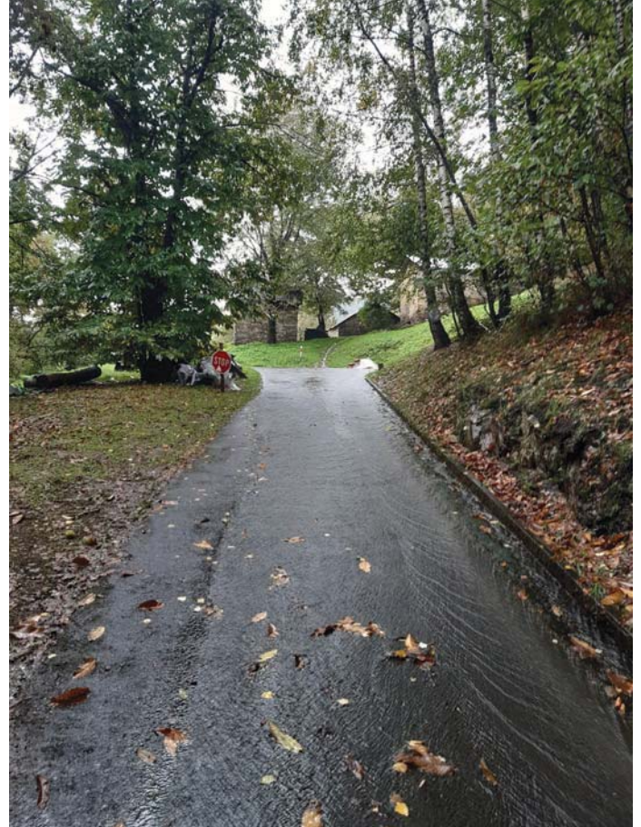
Foto 18 Acqua in strada proveniente dal sentiero Cassinei
