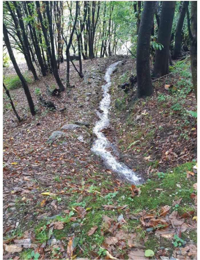
Foto 54 Canale di gronda esistente
