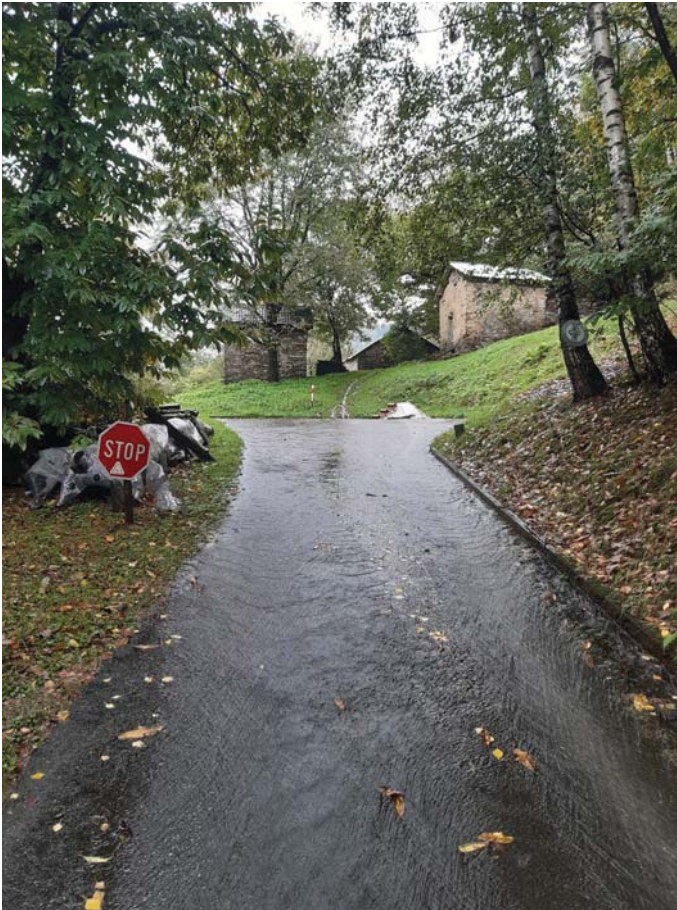
Foto 17 Acqua in strada proveniente dal sentiero Cassinei
