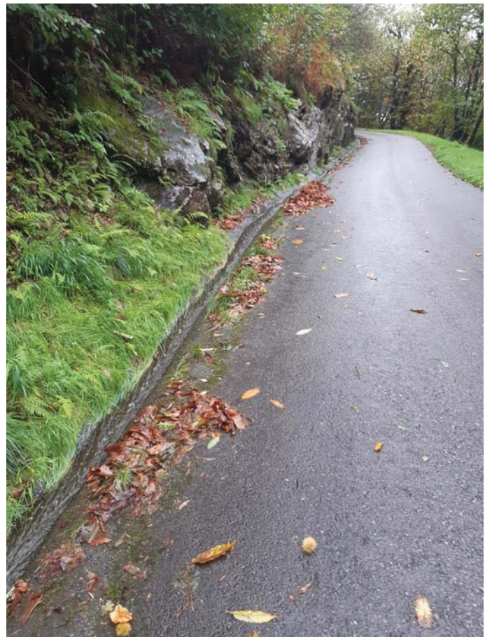
Foto 24 Intevento 2011, canaletta funzionante
