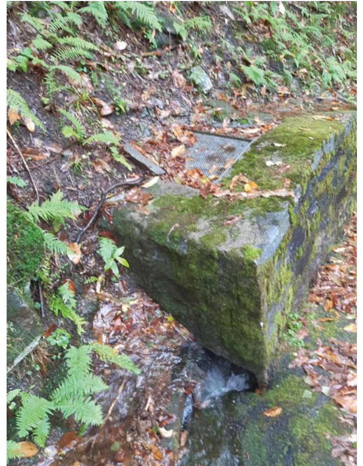
Foto 36 Pozzo da scoprire, Intervento 13
