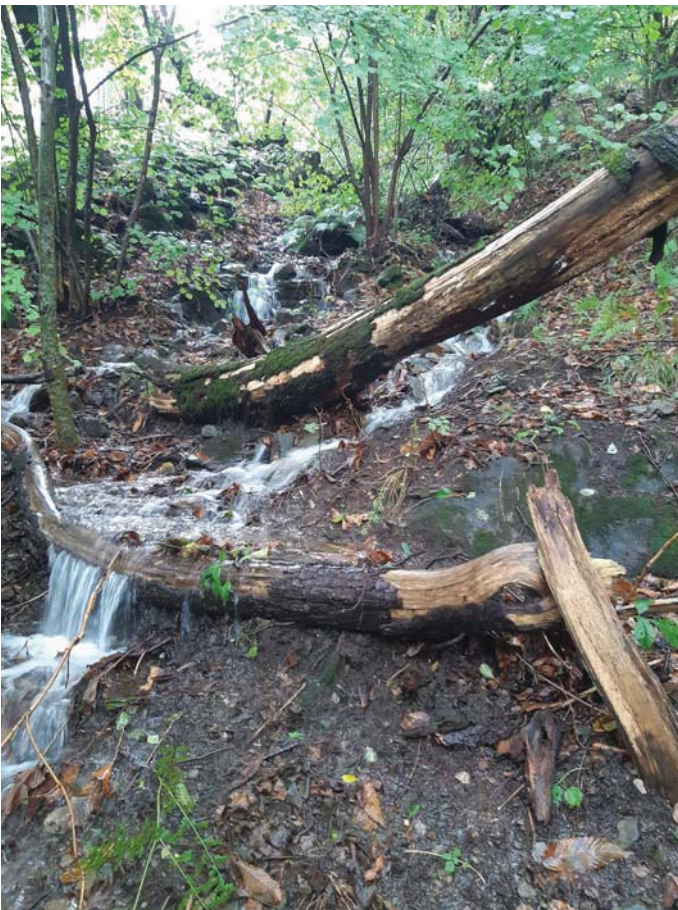
Foto 23 Intervento 7, fuoriuscita riale foto 22
